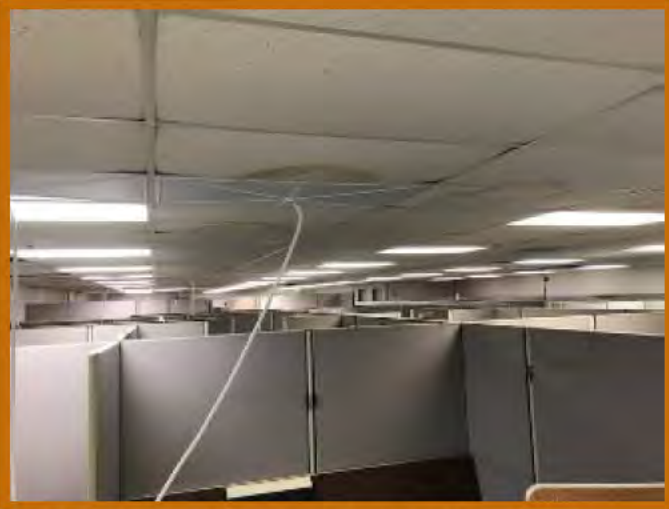
703-47A Renovations (Before)
